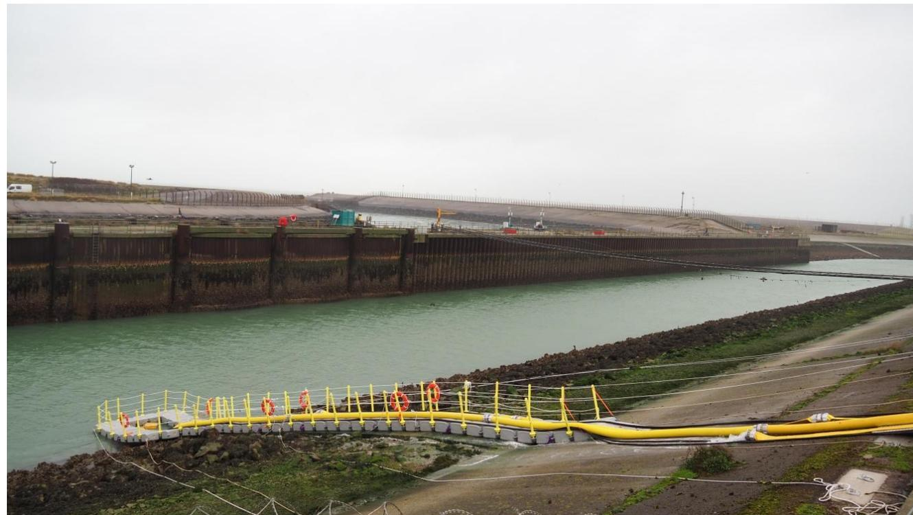
Les tuyaux flexibles permettront de pomper l'eau du canal pour la piscine combustible, en cas de problème.
